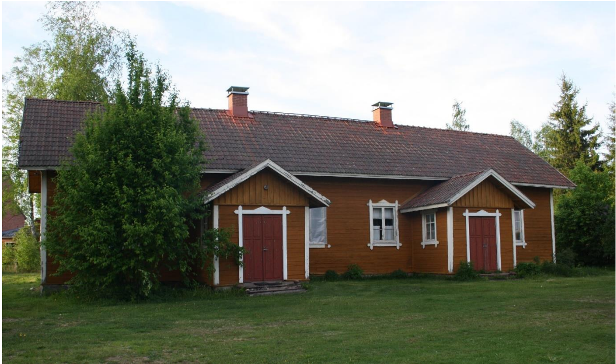
Yttilän koulun asuinrakennuksessa on ikkunoiden korjaus meneillään.
