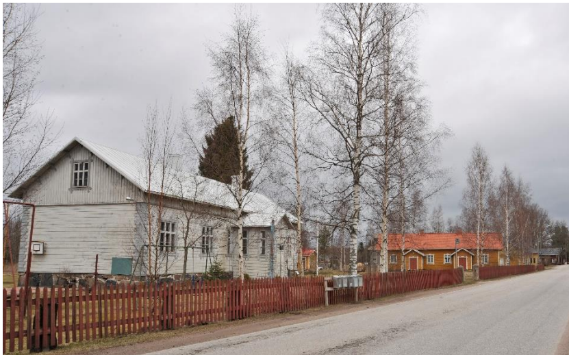
Yttälän museokoulun keittiö kunnostettiin Leader-rahalla. Koulun kunnostukseen voisi hakea myös Kotiseutuliiton seurantalojen korjausavustusta. Kuva: Pentti Pere, Satakunnan Museo.
